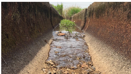
図 29 シークエンスの構成 第 10 章 水田への水の引き込み（撮影：櫻 井宏哉）
