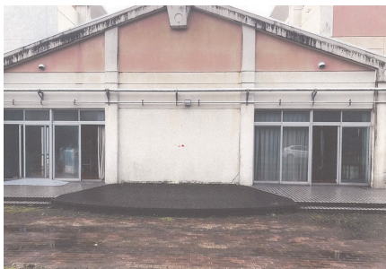
図1 壁画制作前の校舎の壁
