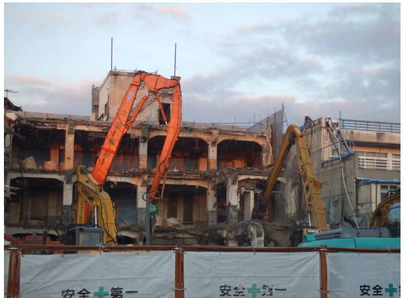
図3 マルビシ百貨店の建物が解体される様子を12月20日に撮影した画像より
